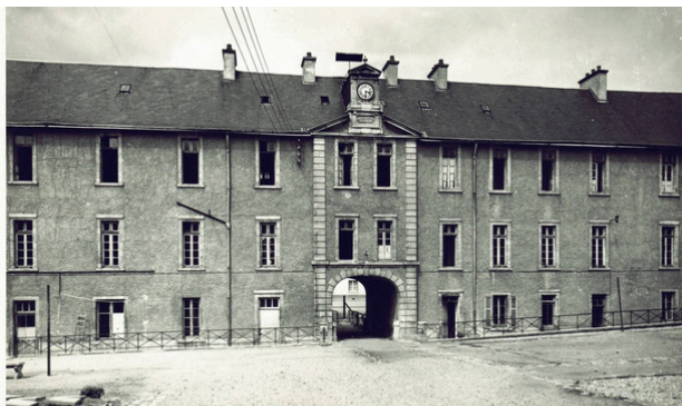
El antiguo pórtico del Hospital de Poitiers
